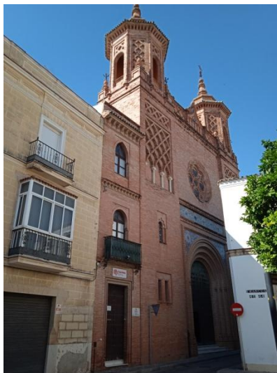
Fachada de la Iglesia del Convento de las Reparadoras de Jerez desde la Plaza de San Juan.
