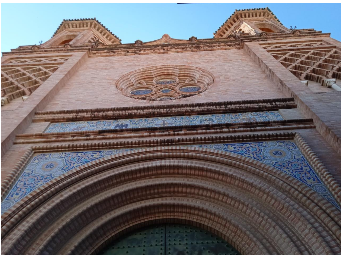
Fachada de la Iglesia del Convento de las Reparadoras de Jerez. Arquivoltas del arco de entrada de ladrillo visto con alfiz y cerámica regionalista
