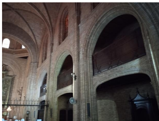
Nave lateral con arco carpanel, arco de medio punto formando la tribuna de la clausura y vidrieras sobre arcos de medio punto. Todo un ejemplo de eclecticismo regionalista.
