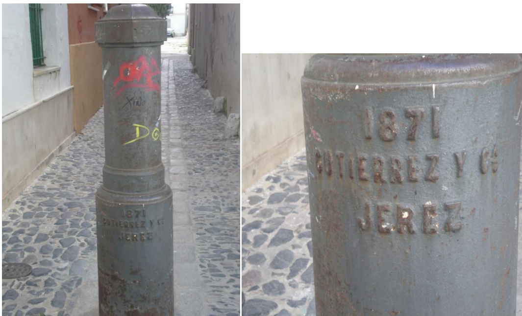
Barrera de hierro para impedir el tránsito rodado en calle Doctor Mercado. Su estado de conservación es lamentable. Gutiérrez y Cía, 1.871
