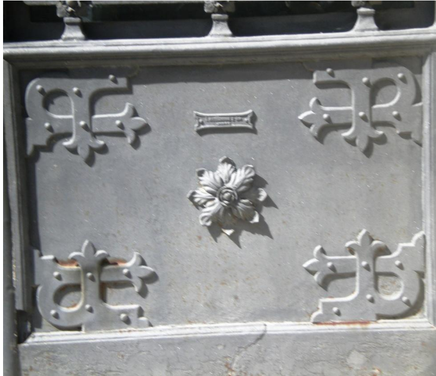
Paño de puerta en la Biblioteca Municipal.
